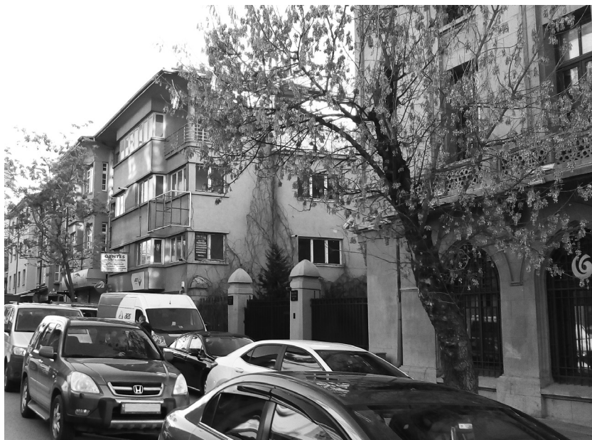
Ilustr. 6. Kamienica, w której na drugim piętrze Gibalkowie znaleźli mieszkanie.
